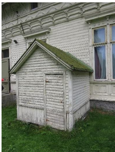
Bild 13. Pumphus utanför kök, finns ej inritat på planritning, har byggts till senare.
