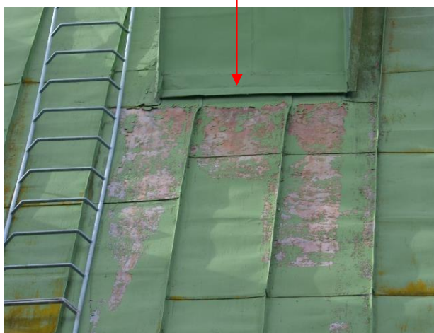
Bild 17 och 18. Färgen flagar ställvis på takplåten. Ställvis finns rostangrepp.
