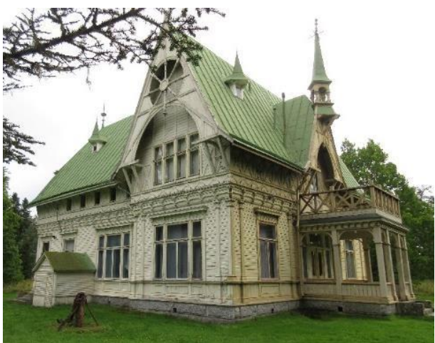
Bild 11. Nyansskillnad på fasaden. Den södra sidan ommålad.
