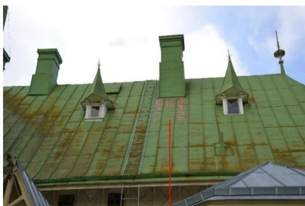
Bild 17 och 18. Färgen flagar ställvis på takplåten. Ställvis finns rostangrepp.
