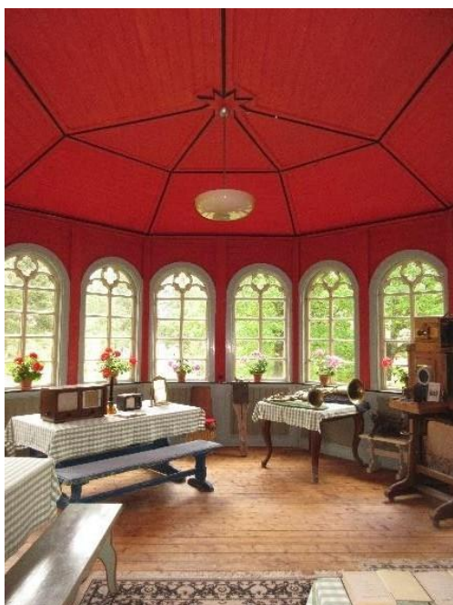
Bild 38. Glasverandan har fått nytt tak och nytt golv.
