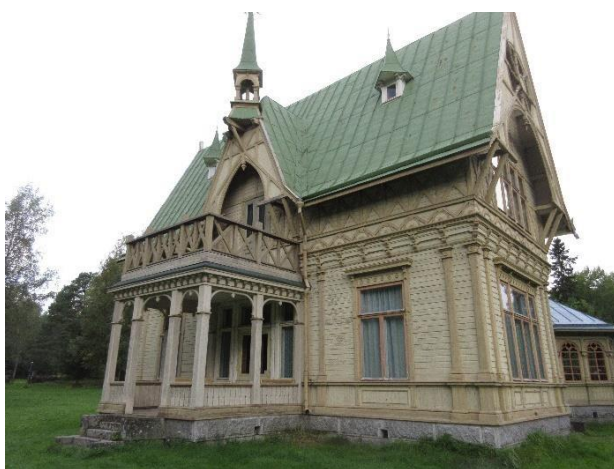
Bild 3. Fasad mot söder.
