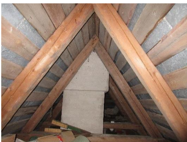
Bild 31. Skorsten och taknock på våning 3.
