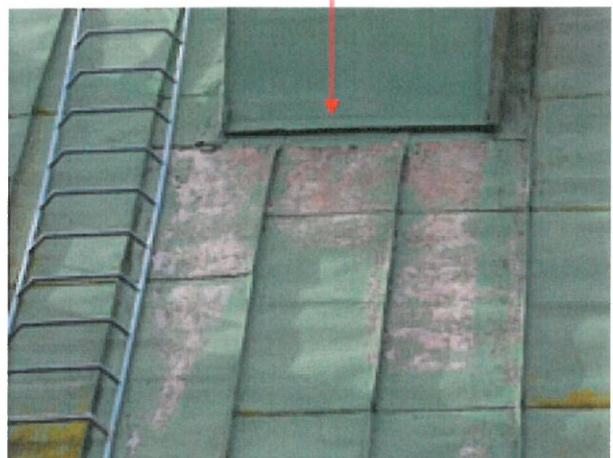
Kuva 17 ja 18. Kattopellin väri lohkoilee paikoittain. Ruostevaurioita paikoittain.
