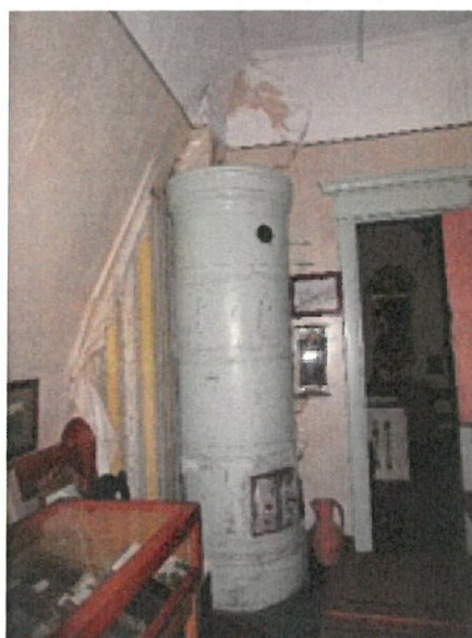
Kuva 54. Merkkejä kosteudesta muurin ympärillä, 2. kerros.
