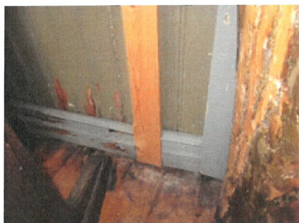
Kuva 40. Lasiveranta, merkkejä ulkoa tunkeutuvasta kosteudesta, luultavasti yhteyttä kuvan 6 kanssa.
