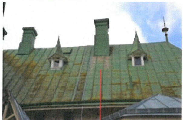
Kuva 17 ja 18. Kattopellin väri lohkoilee paikoittain. Ruostevaurioita paikoittain.
