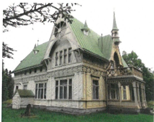
Kuva 11. Vivahde-ero julkisivussa. Eteläinen seinä on uudelleen maalattu.
