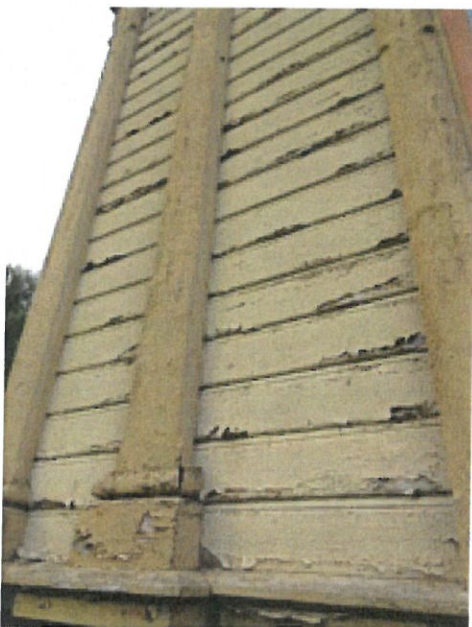
Kuva 9. Väri lohkoilee julkisivussa.
