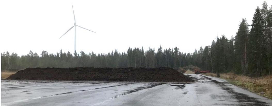
Kuva 5. Näkymä kompostointikentän suuntaan © Ramboll Finland Oy.
