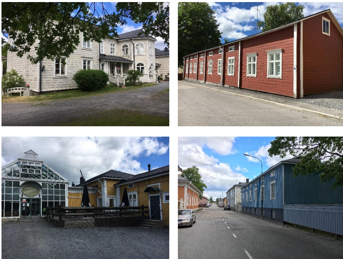
Bild 4. Byggnationen inom planläggningsområdet består av äldre hus som delvis restaurerats och renoverats. Byggnaderna i bilderna ovan finns alla i kvarter 238 men berörs inte alla av planändringen.
