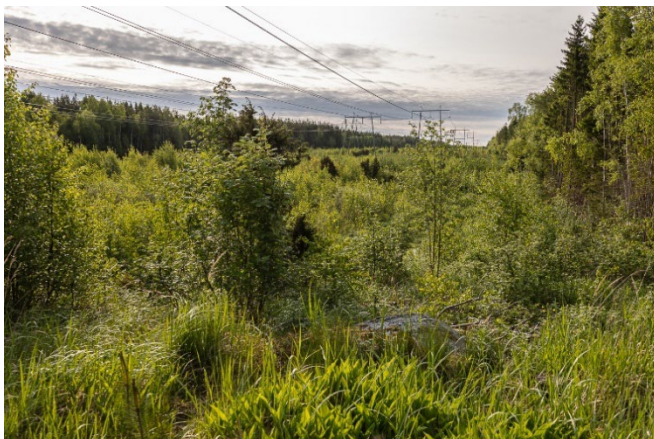
Bild 5. Kraftledningslinjen i norra delen av inventeringsområdet.
