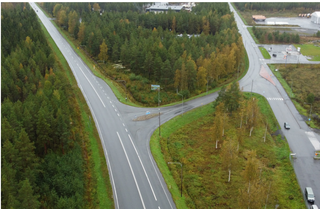
Bild 13. Korsningen från Riksväg 8 till Södra Lappfjärdsvägen. Korsningen försedd med väjningsfilar samt mittrefug.
