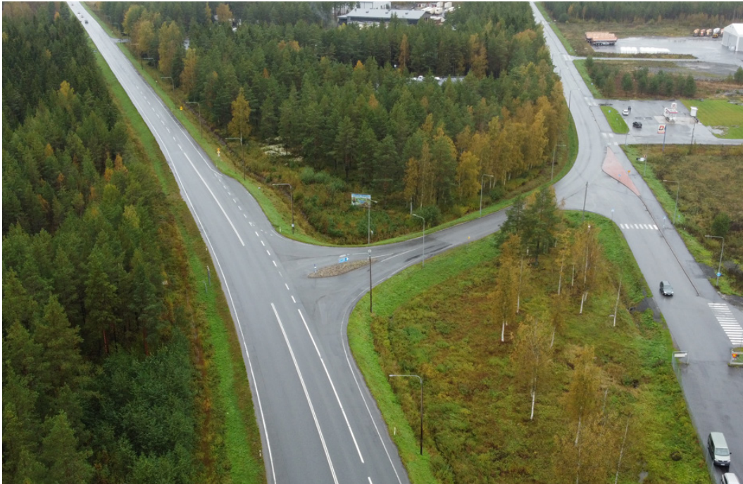
Bild 13. Korsningen från Riksväg 8 till Södra Lappfjärdsvägen. Korsningen försedd med väjningsfilar samt mittrefug.
