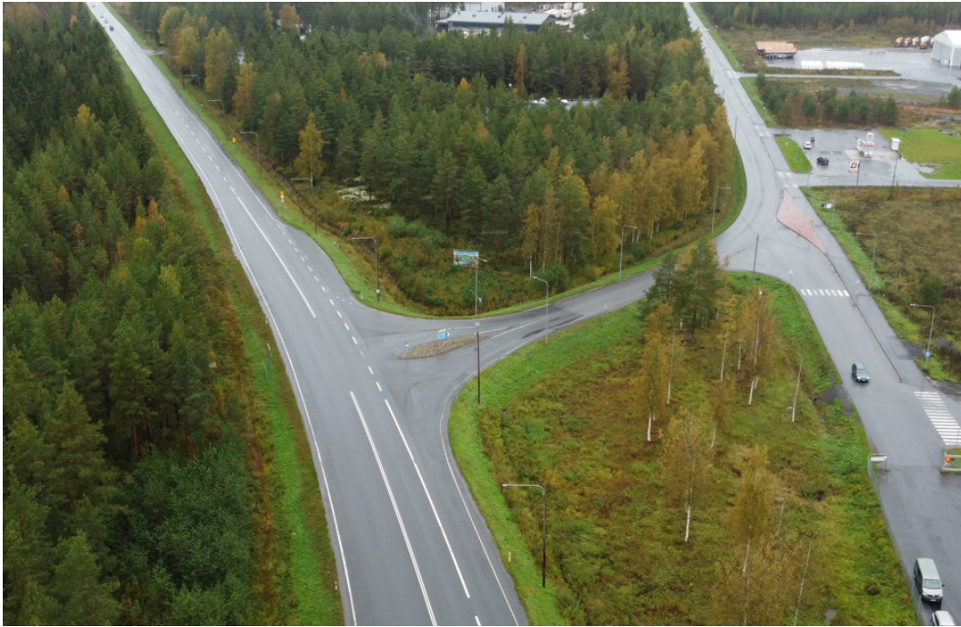
Kuva 13. Liittymä valtatieltä 8 Eteläiselle Lapväärtintielle. Liittymä varustettu väistämisluskoilla ja keskikorokkeella.
