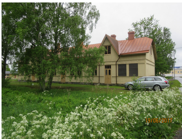
Kuva 8. Kohde 2 kuvattuna vuonna 2017. © Ramboll
