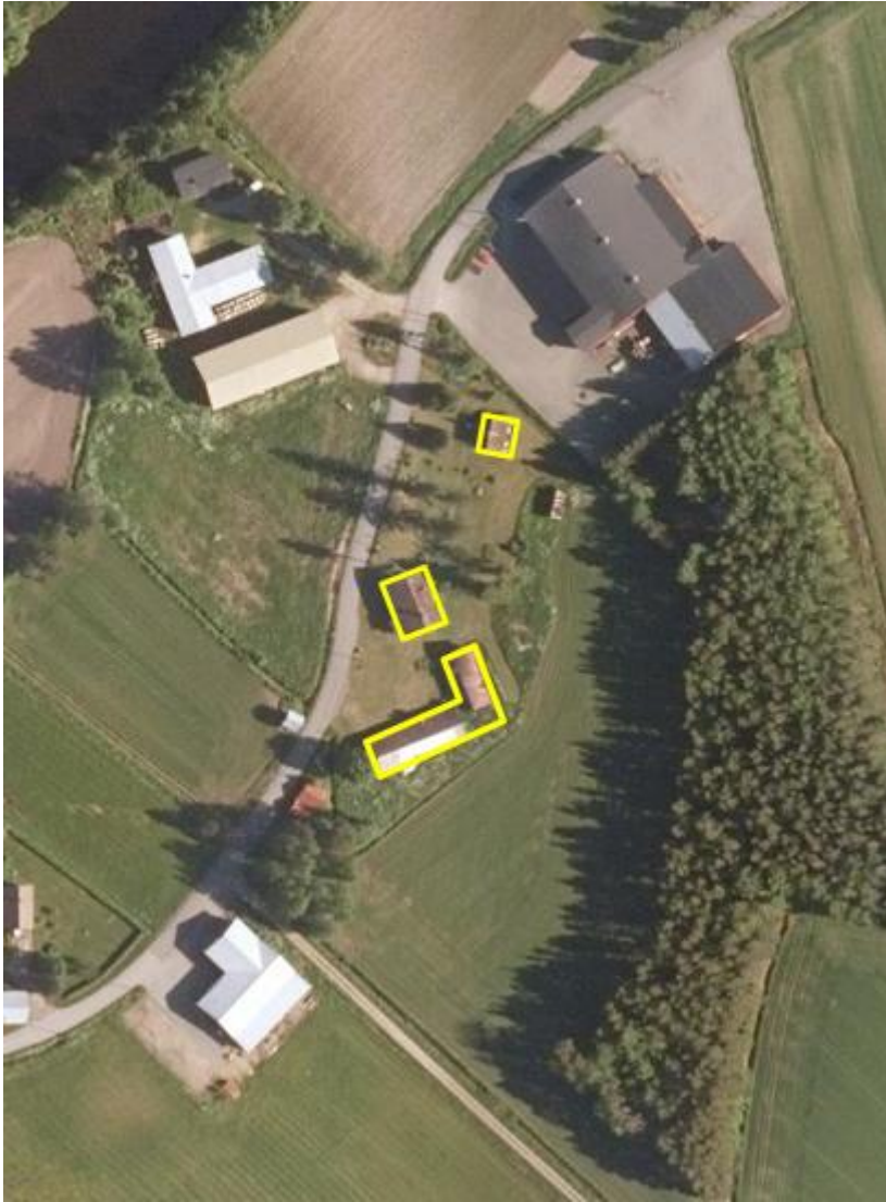
Kuva 7. Jäljellä olevat kohteet, joita purkulupa koskee.
