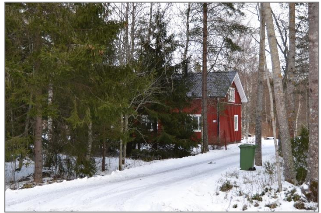
Kuva 12. Skrattnäsintie 45 (kohde 2) on naapurinsa ohella alueen vanhimpia taloja. Puolitoistakerroksinen, harjakattoinen, pystyrimavuorattu asuinrakennus on säilyttänyt rakentamisajasta kertovat piirteensä. Vanhan ulkorakennuksen tilalle rakennettiin uusi sauna- ja talousrakennus 1990-luvun lopussa. (KRIS.)
