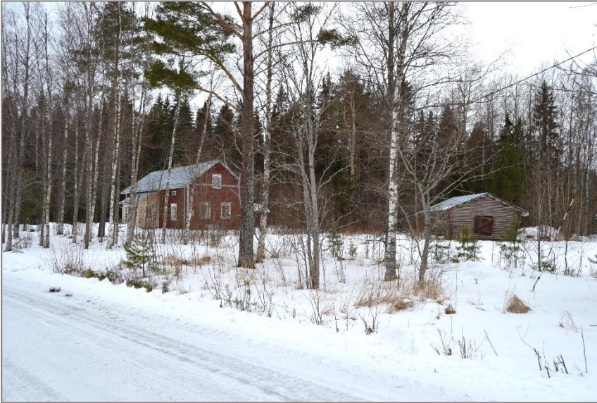
Kuva 31. Carlsrontie 268:n pihapiiriin kuuluu hirsinen latorakennus.
