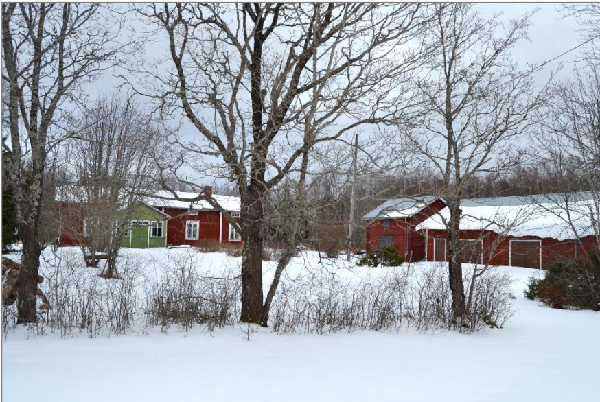
Kuva 32. Tien itäpuolella sijaitseva Lintulan vanha päärakennus ja pihamiljöö on rantayleiskaavassa osoitettu suojeltavaksi.
