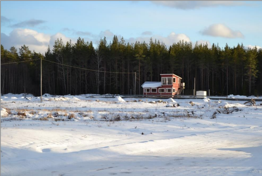
Kuva 25. Moottoriradan toimitsijarakennus kuvattuna rata-alueen yli pohjoisesta.
