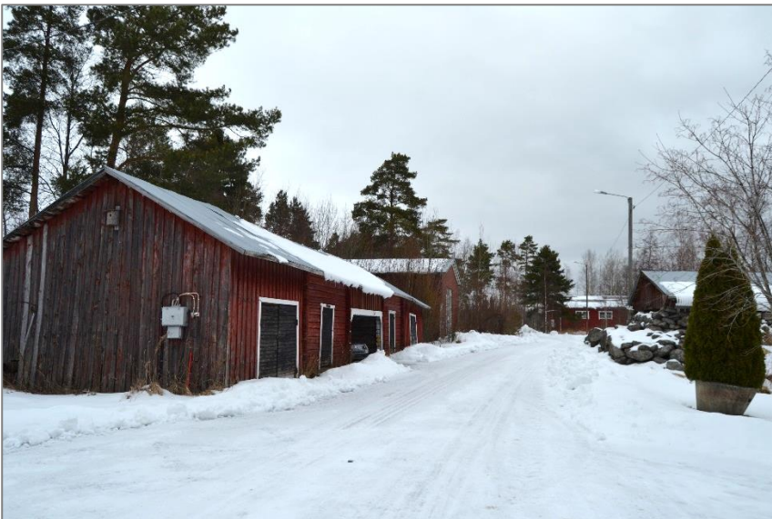
Kuva 30. Lintulan vanha talousrakennus (kartassa nro 16) rajaa Carlsrontietä. Tien toisella puolella näkyy Lintulan kivikellari. Kuvaussuunta pohjoiseen.
