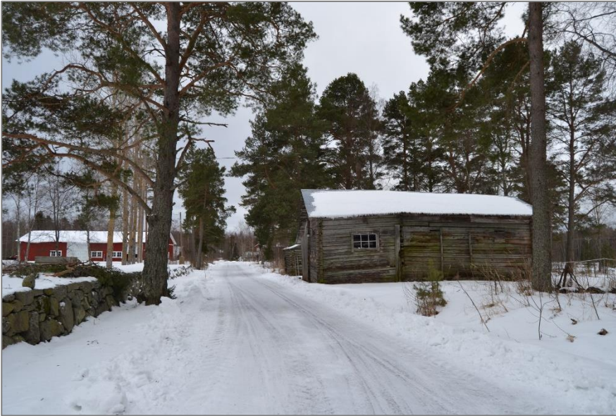
Kuva 33. Carlsrontien reunalla selvitysalueen puolella sijaitsee kaksi hirsistä talousrakennusta (kartan nro 17). Kuvaussuunta etelään.
