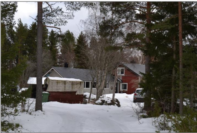
Kuva 15. Pormestarintie 17 (kohde 5) on rakennettu vuosien 1957 ja 1971 välillä. Asuinrakennuksen lisäsiipi on todennäköisesti rakennettu myöhemmin.
