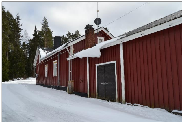
Kuva 35. Päärakennuksen pohjoissivua. Vanha osa (kuvassa lähimpänä) on perustettu luonnonkivien varaan.
