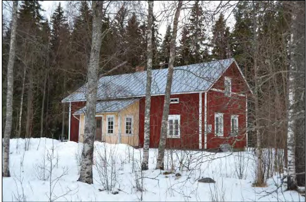
Rakennetun kulttuuriympäristöselvityksen (Heilu Oy 2023) kuva Carlsrontien 268 päärakennuksesta.
