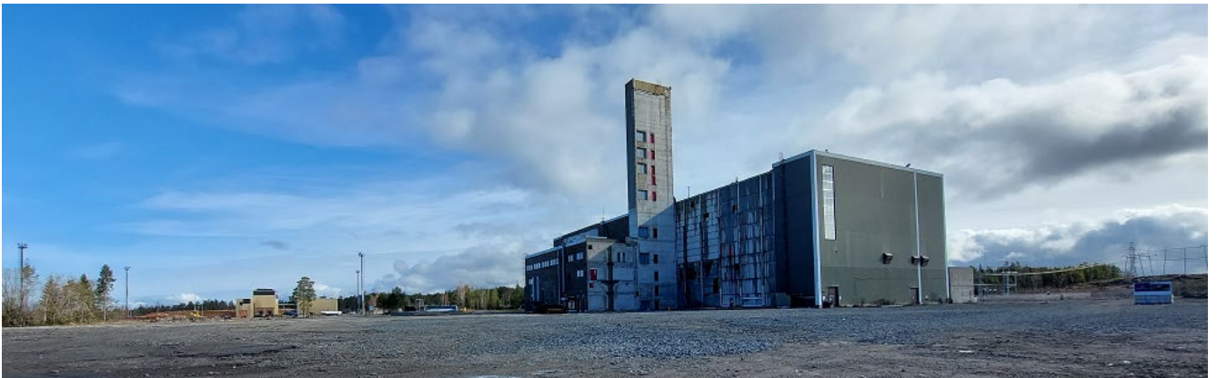
Kuva 8. Kuva lounaissuunnalta teollisuusalueelle, avoin alue jatkuu sähkölinjojen suuntaan kuvan oikeassa reunassa. (kuvan lähde: Ramboll 04/2023).
