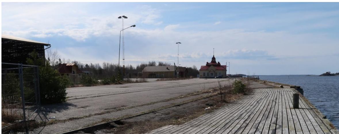
Bild 15. Mot vattnet finns en hög hamnkonstruktion i nuläget © Lantmäteriverket.
