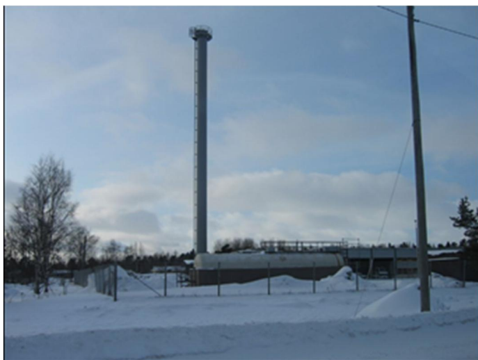
Reservvärmecentral med oljecistern i områdets södra del.
