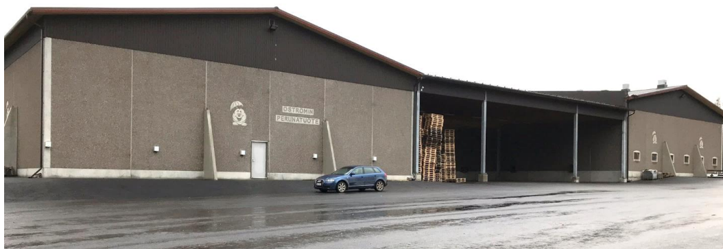
Kuva 4. Näkymä tuotantorakennusten suuntaan © Ramboll Finland Oy.
