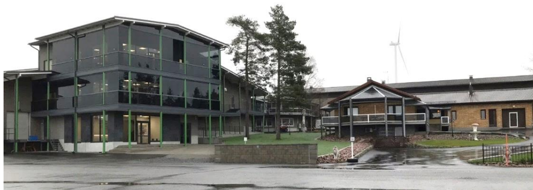
Bild 4. Vy från parkeringsområdet mot kontorsbyggnaderna, i bakgrunden syns ett vindkraftverk och produktionsutrymmen © Ramboll Finland Oy.
