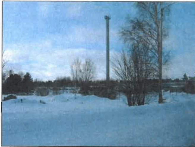
Vy över planeringsområdet från Närpesvägen. I förgrunden den nya värmecentralen.
