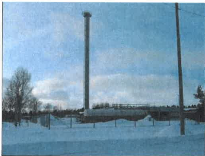
Reservvärmecentral med oljecistern i områdets södra del.
