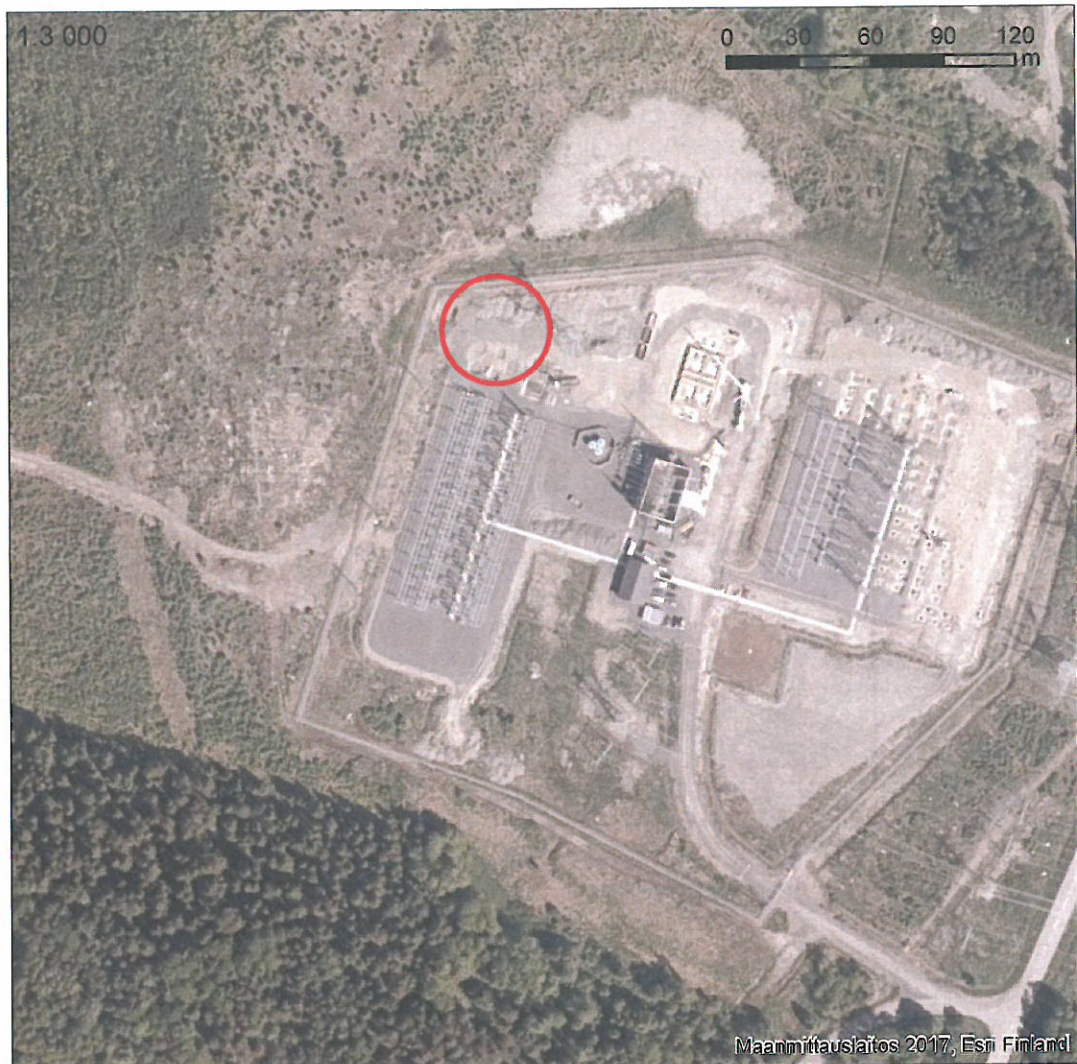
Kuva 6. Todennäköinen liittymiskohta (punainen ympyrä) Kristiinankaupungin sähköasemalla.
